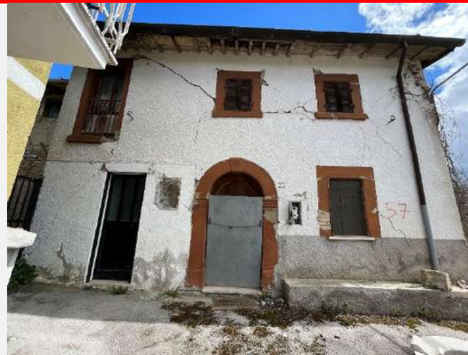
Fig. 7 - Fig. 123 Part. 57 Prospetto ovest
