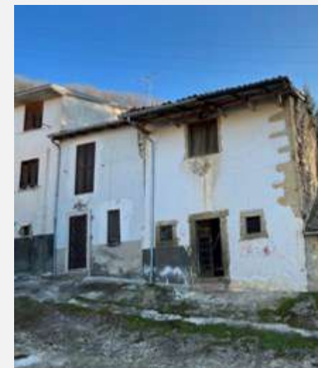
Fig. 14 - Fig. 123 Part. 66 Prospetto ovest
