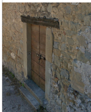
A Apertura con sistema a trillite ed architrave in legno
